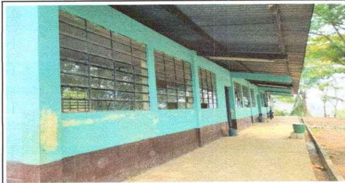
Foto 3: Se observa el deterioro de la pintura exterior de la escuela.
