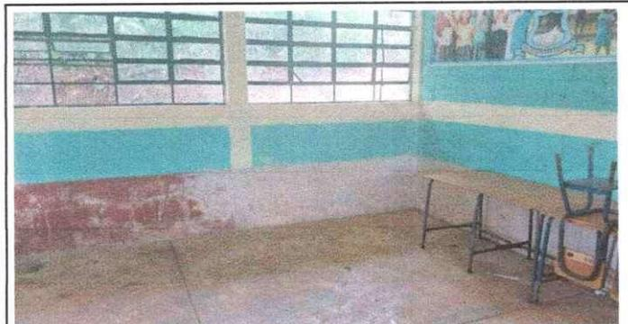
Foto 5: Se observa el deterioro de la pintura interior de la escuela.
