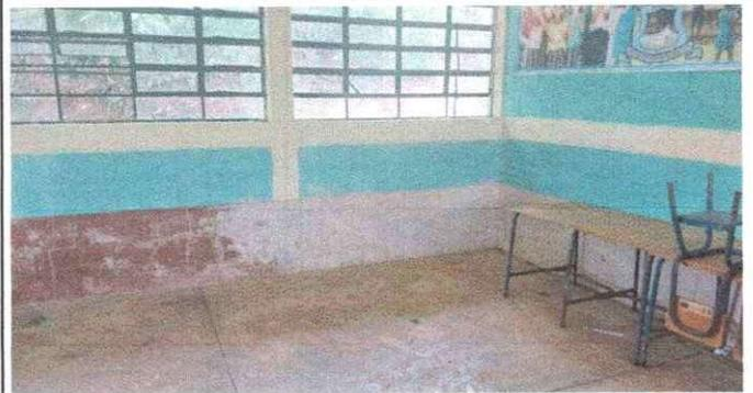
Foto 2: Se observa el deteriro del piso del aula.
