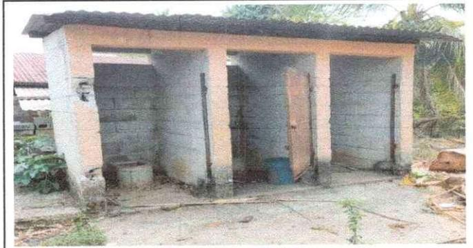
Foto 6: Se observa el deterioro de las puertas, pared y el entechado del baño.
